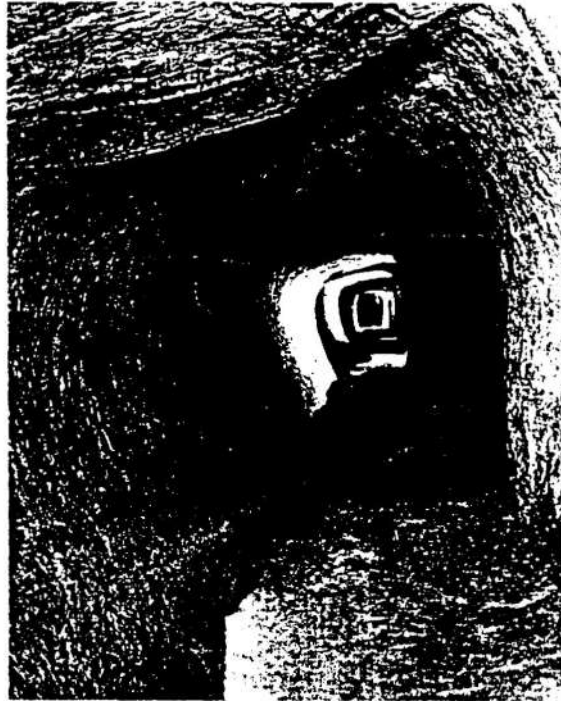
3. Samos: tunnel di Eupalino. L'acqua veniva trasportata in una condotta posta sul fondo della trincea, lungo la parte sinistra del fondo del tunnel principale (foto Deutsche Archaisches Institut. Atene )
